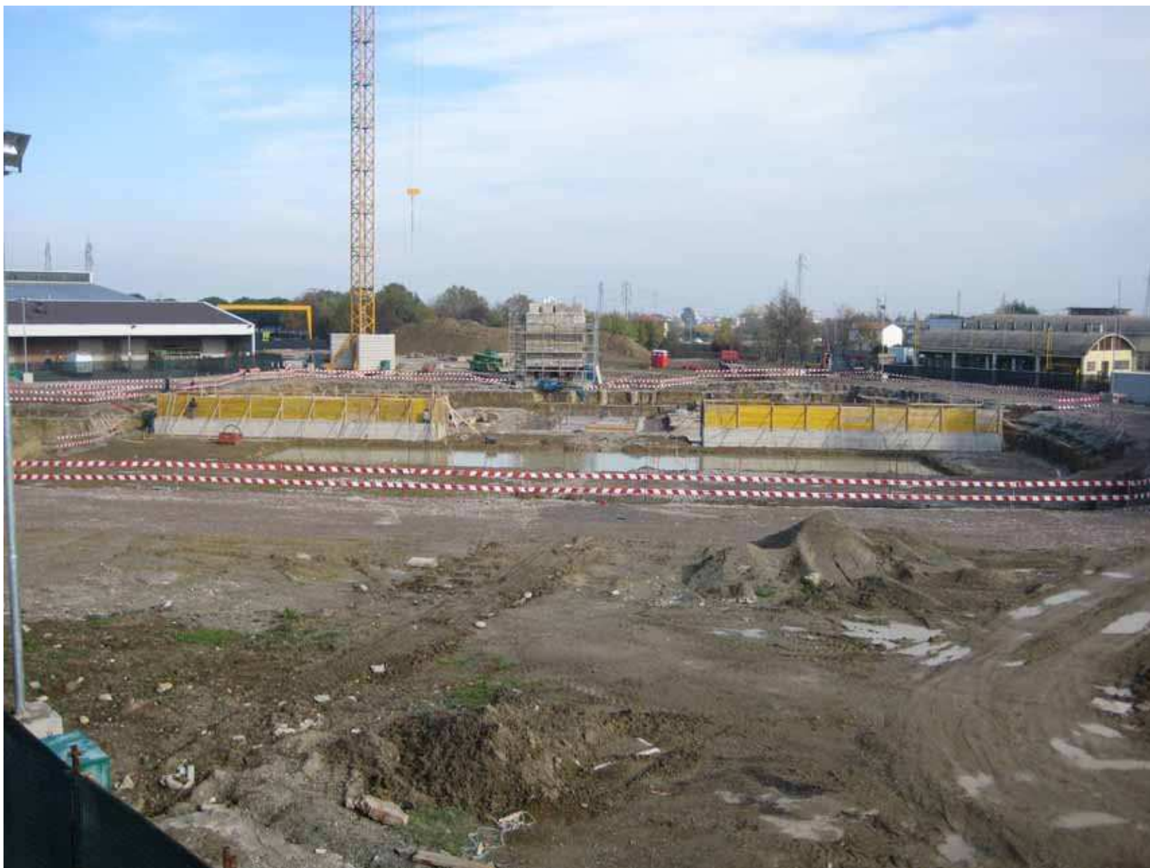
CCGT Imola ( cantiere )
