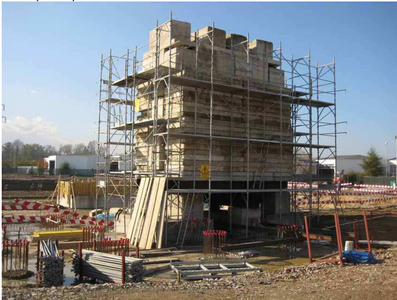
CCGT Imola ( cantiere )
