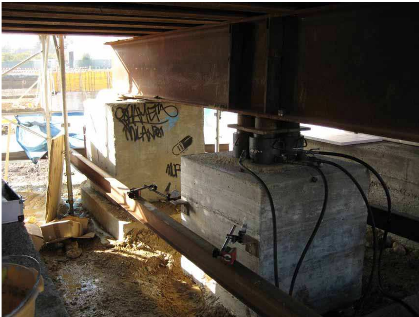
CCGT Imola ( cantiere )
