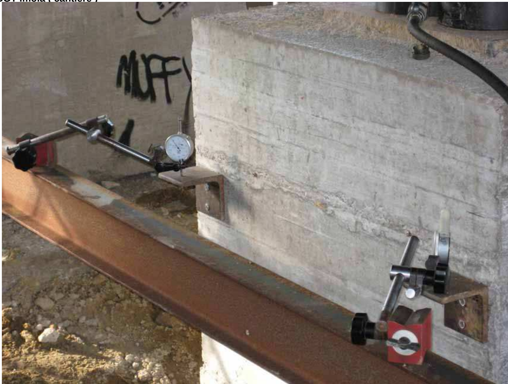
CCGT Imola ( cantiere )
