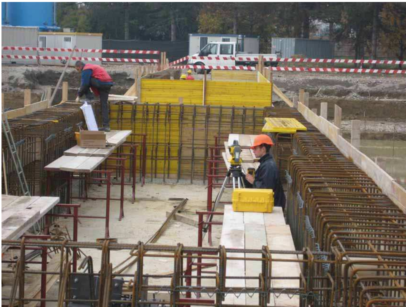
CCGT Imola ( cantiere )
