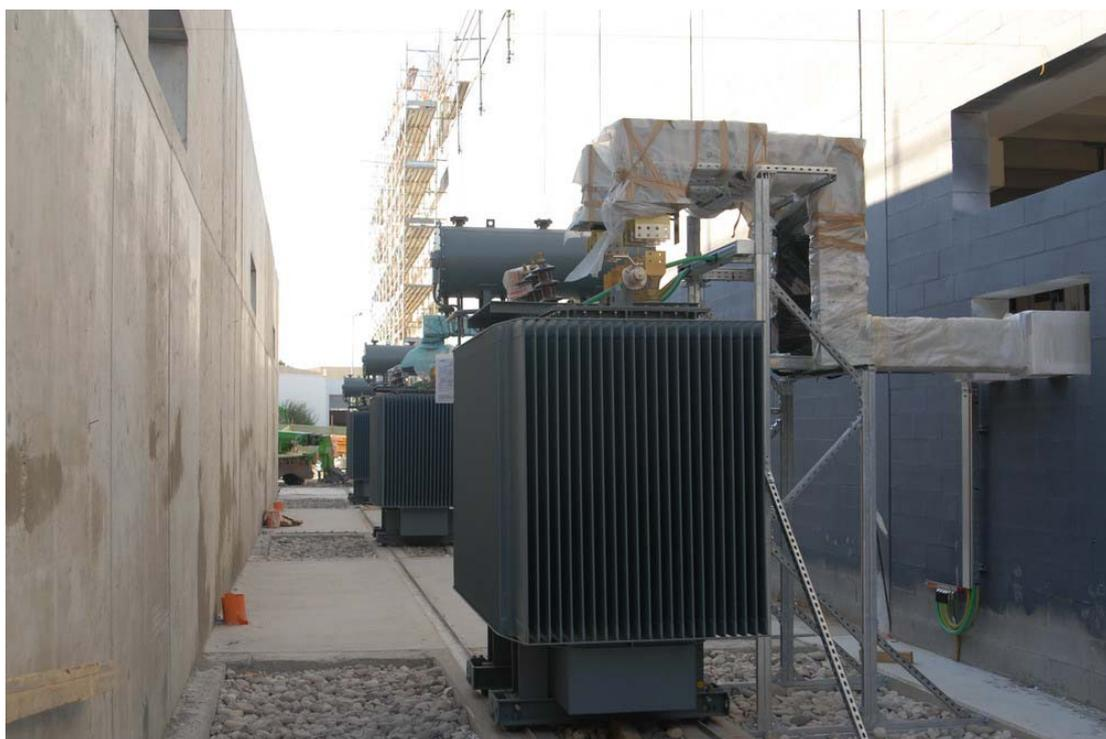
Montaggio della sezione elettrica di trasformazione da media a bassa tensione
