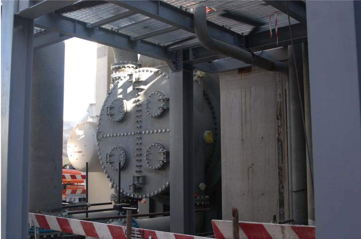
Condensatore e scambiatore per l'alimentazione del teleriscaldamento
