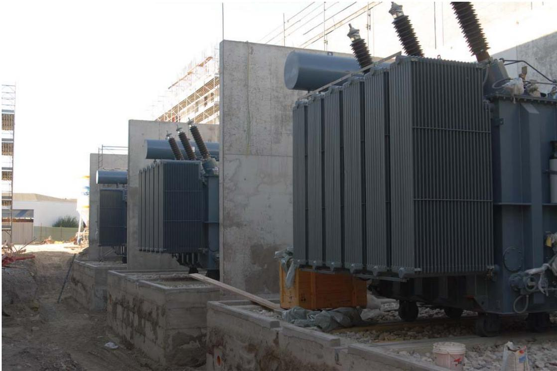
Montaggio della sezione elettrica di elevazione da media ad alta tensione
