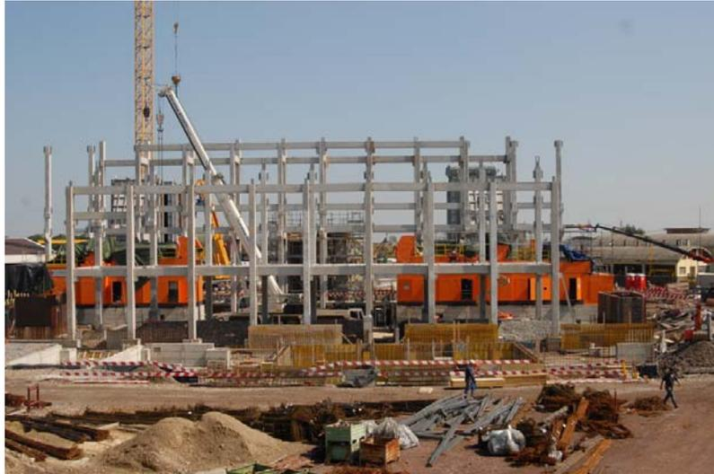
Sono stati installati i Cabinati delle Turbine a Gas (senza all'interno i motori).
