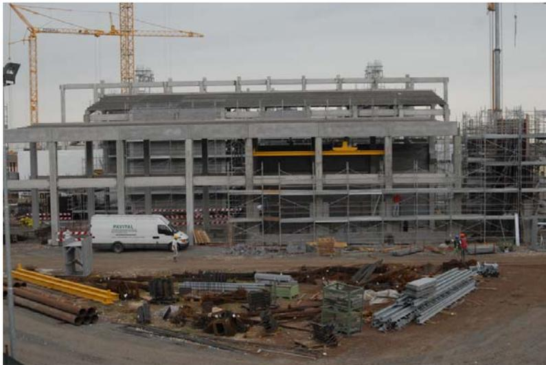
Sono stati installati i due SCR tra le caldaie.
