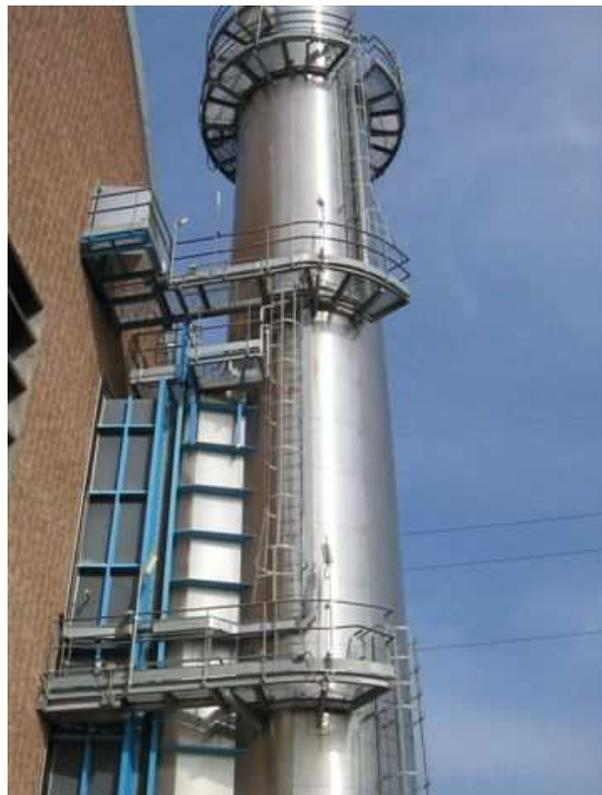
L'ing. Ghizzoni ci ha spiegato il funzionamento dell'SCR: in sostanza con questo dispositivo si può regolare il valore di NOx iniettando un valore più o meno alto di ammoniaca (NH3). Teoricamente si potrebbe arrivare al completo annullamento degli NOx ma con un trascinamento di NH3 al camino. La gestione automatizzata, in quel momento, stava regolando l'NH3 in modo da avere il minor valore di NOx senza fuoriuscita di ammoniaca dal camino.
